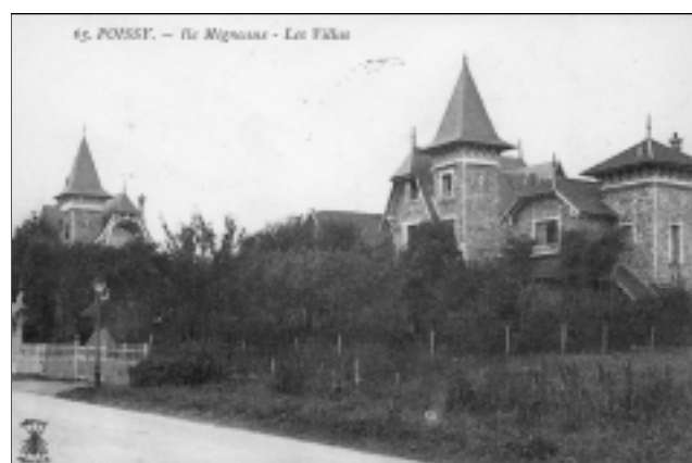
Sur la gauche, le bec de gaz au n° 22 de l'île ; le réverbère électrique sera placé devant le n° 24.
