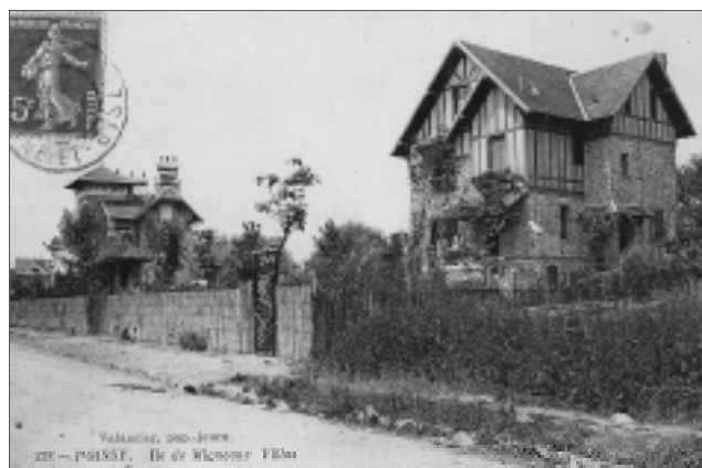
Villas n°30 (Le Val Fleuri) et 32 (Les Terrasses) dans l'île.
