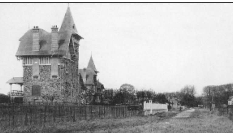
Jusqu'en 1927, l'avenue de l'île s'arrête au n° 28 (la villa n'a encore qu'une seule de ses deux tourelles).
