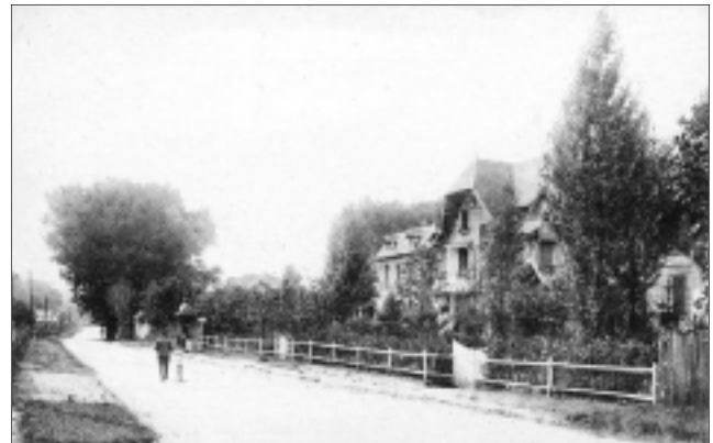
Villas anglo-normandes aux n° 4 (Marjolaine), 6 (Le Clos Normand), et 8 (L'Evasion) dans l'île ; le vieux peuplier étêté au fond marquera l'emplacement du futur pont de Migneaux.
