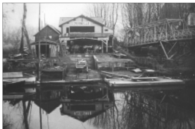
Le garage Pernelle et la passerelle en bois.
