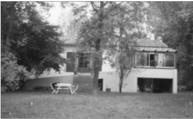
La “Ferme” côté Petit Bras de Seine, dans les années 1980. Remarquez le plan incliné aujourd’hui transformé en terrasse (Photo M. Chalmin).
