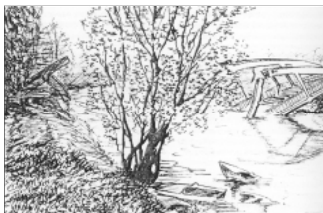
Le pont en bow-string de l'île de Vaux après le 9 juin 1940 (3). On notera la principale différence architecturale avec le pont de Migneaux : à Vaux, les suspentes étaient alignées avec le garde-corps, et non à l'intérieur du tablier.
